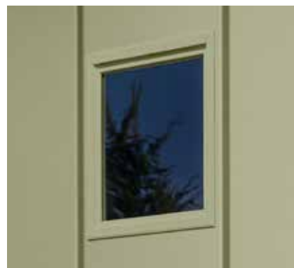
Przeszkłone elementy z szybami z tworzywa sztucznego
